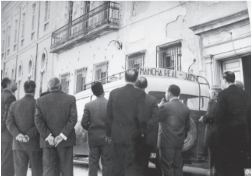
Miembros de la Junta de Oficiales observando los destrozos que provocó en la parte posterior del edificio de la Real Sociedad el bombardeo de 1 de abril de 1937.
